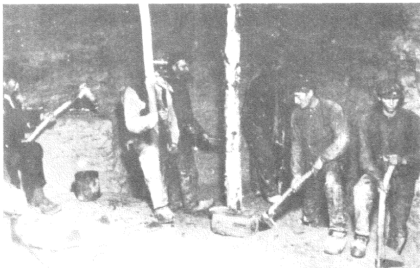
Lossning av ett kvarntensämne i ett underhack 1914. Foto: J.A. Ekelöf.
