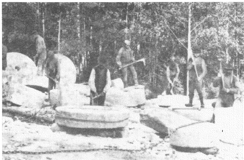
Kvarnstenen jämnas och finhugges innan den sänds iväg för försäljning. Mannen nr 2 från höger i rundkullig hatt är JA Ekelöf. Foto: E. Almqvist. Ca 1900.
