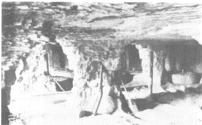
Det inre av kvarnstensbrottet vid Kulpängen, Lugnås. För undvikande av ras har man här och där lämnat grova sandstenspelare.
